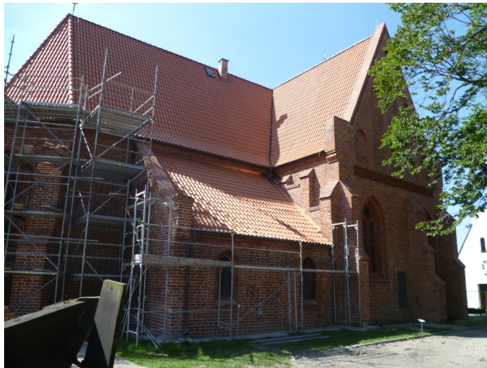
Fot. Nr 2. Budynek Muzeum Rybołówstwa - widok od strony północnej
