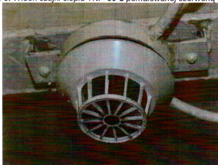
Fot. 10. Widok jonizacyjnej czujki dymu DIO-37 zainstalowanej w miejscu gdzie pierwotnie była zainstalowana jonizacyjna czujka dymu DIO-30, statek SS Soldek
