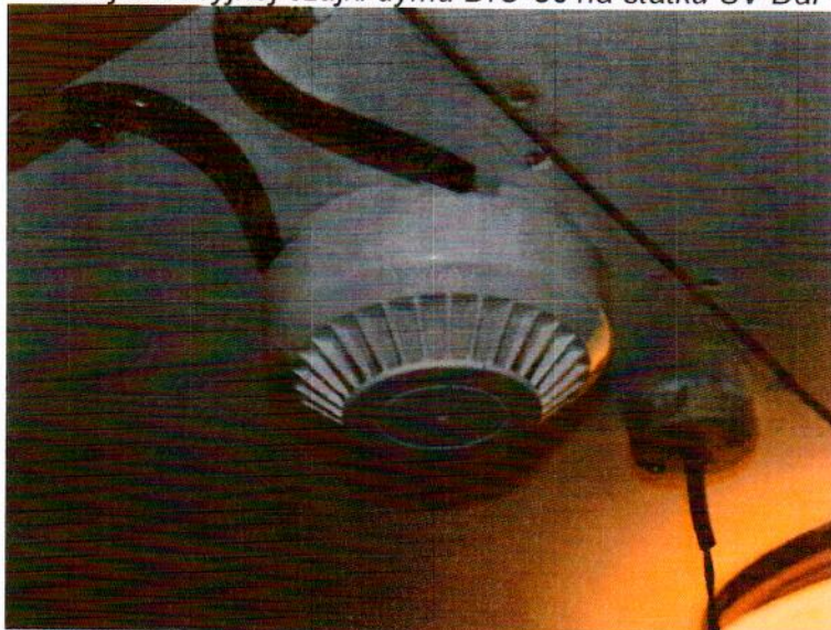
Fot. 15. Widok czujki ciepła TUP-40 na statku SV Dar Pomorza
