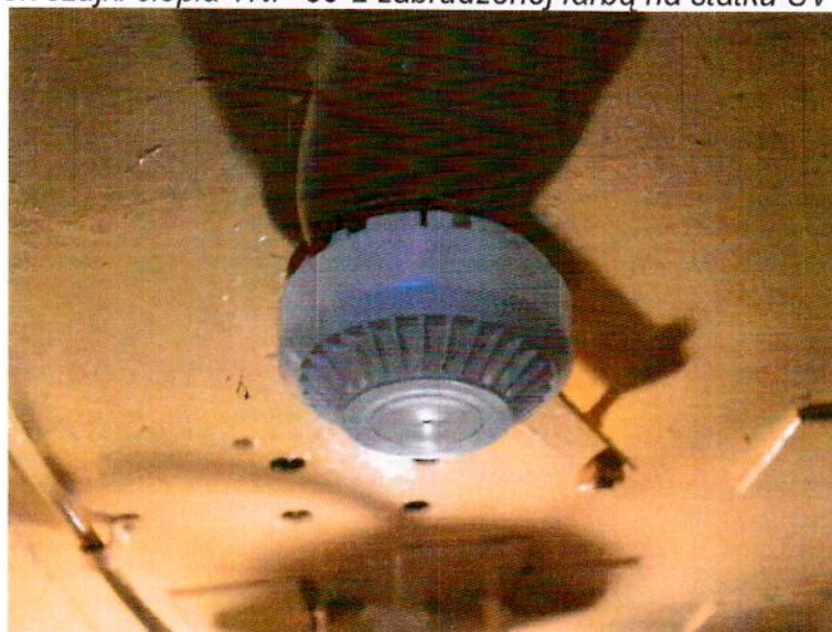
Fot. 18. Widok czujki ciepła TUP-40 wpiętej w miejsce czujki dymu w pomieszczeniu międzypokład I na SV Dar Pomorza
