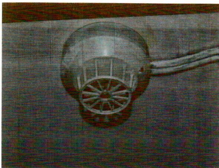
Fot. 17. Widok czujki ciepła TNP-30-2 zabrudzonej farbą na statku SV Dar Pomorza
