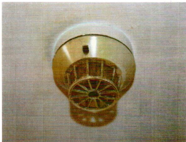
Fot. 3. Widok zabrudzonej czujki ciepła TNP-30-2 na statku SS Soldek
