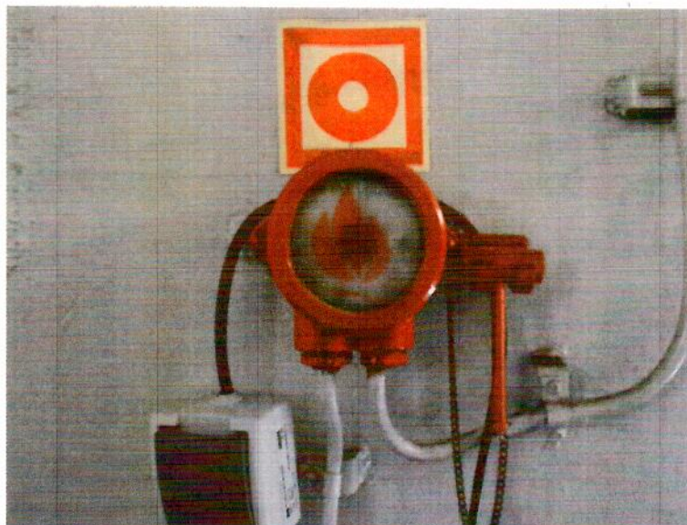
Fot. 6. Widok ręcznego ostrzegacza pożarowego
