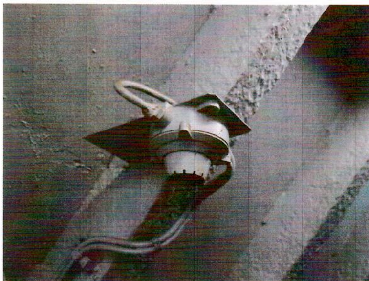
Fot. 7. Widok czujki dymu typu DIO-30 na statku SS Soldek
