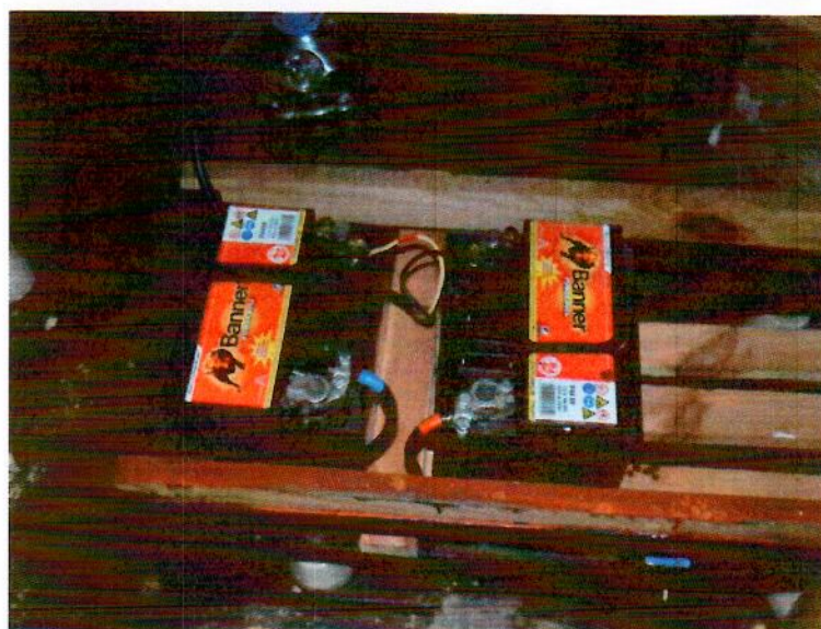
Fot. 8. Widok akumulatorów zastosowanych w systemie sygnalizacji pożarowej na statku SS Soldek
