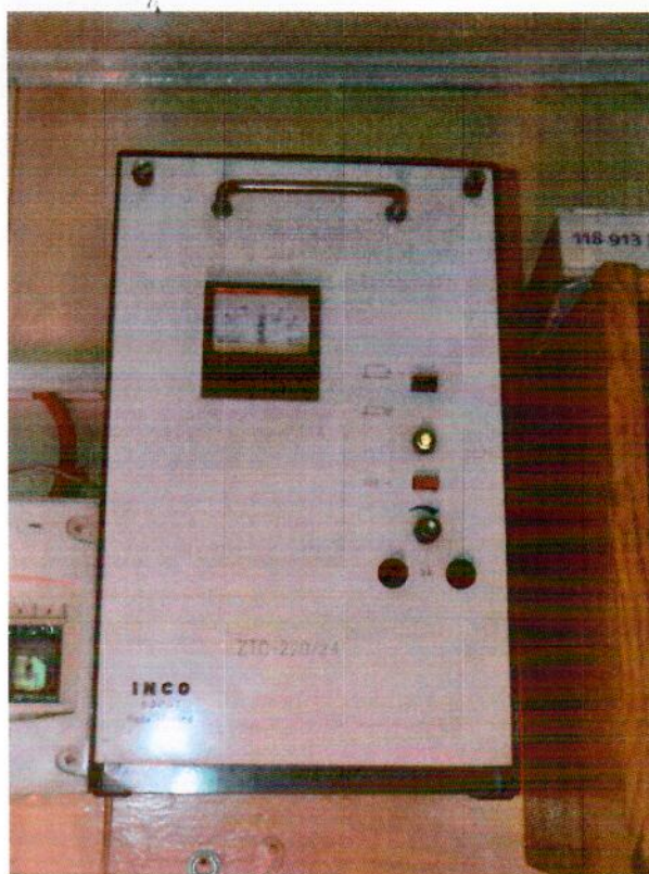
Fot. 2. Widok zasilacza systemu sygnalizacji pożarowej typu ZTC-220/24 na statku SS Soldek
